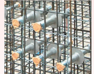
電線管スリーブ施工例
