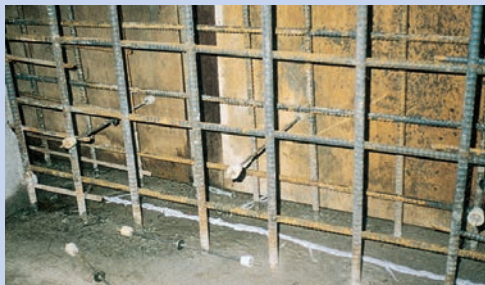
コンクリートの打ち継ぎ目に…
